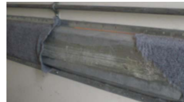
Indtræk og stænger: Revnet eller løst tæppe
