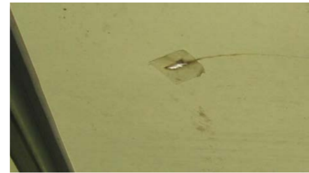
🔧 Loftsrums: Hullet eller revne, som kan betale sig at reparere
