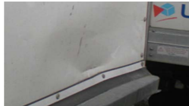
🔧 Side- og bagdøre: Betydelig deformation: Reparationstid > 1 t, kan betale sig at reparere, lukning ikke tætsluttende
