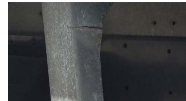
Læssesmæk: Deformationer af platform, som kan betale sig at reparere
