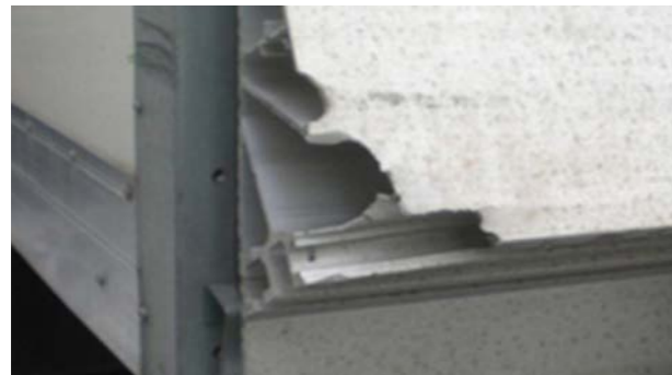
↻ Læssesmæk: Deformationer på platformen, som ikke kan betale sig at reparere, brudt eller ufuldstændig beklædning
