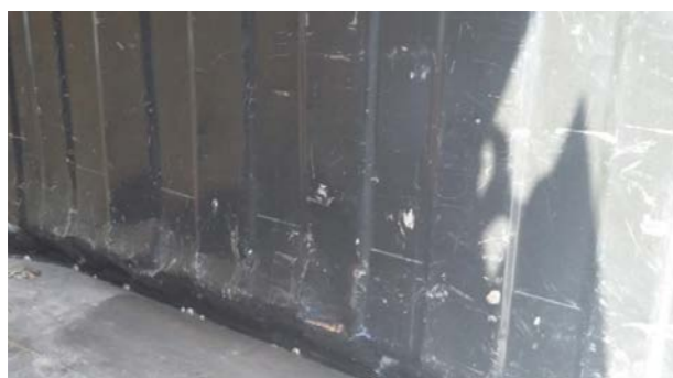
Indvendige deformationer: Mindre deformationer uden huller eller hak, reparationstid ≤ 3 t
