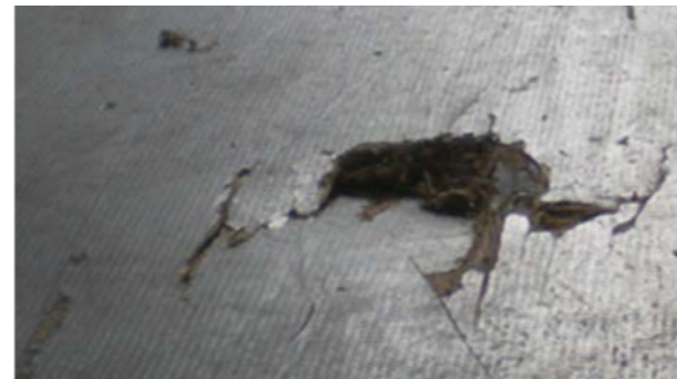
🔧 Gulvbelægning: Deformationer eller huller, som kan betale sig at reparere
