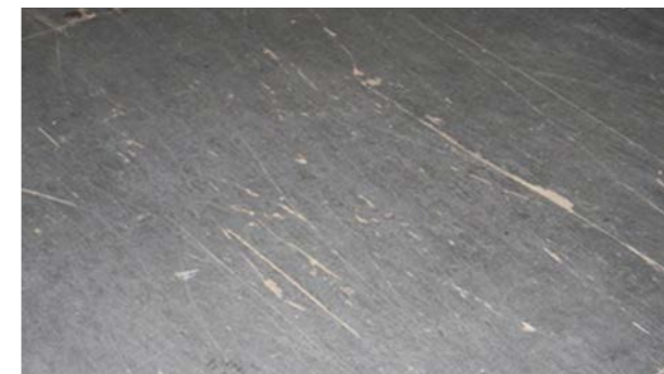
Gulvbelægning: Mindre deformationer, overfladisk slitage
