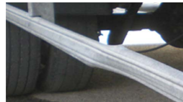
Cyklistværn: Deformationer, som ikke kan betale sig at reparere
