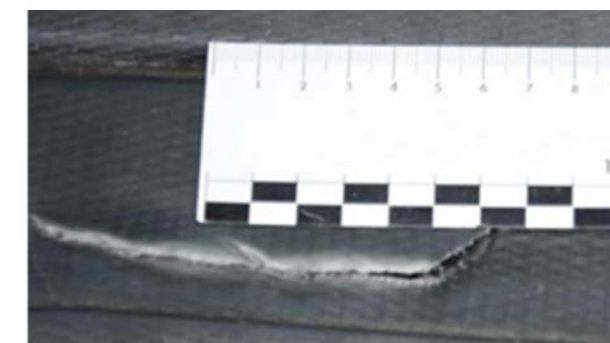
Huller i beklædningerne af hård plast. Reparation af beklædningerne af hård plast i times enhedsats hvis æstetisk acceptabelt og reparerbart
