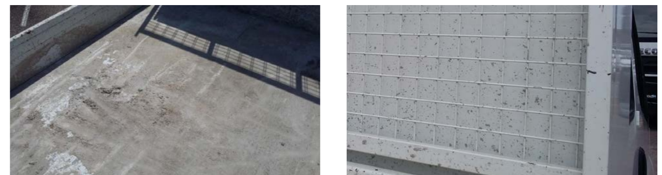
🔧 Ślady betonu lub produktu chemicznego zajmujące \geq \frac{1}{4} powierzchni zbiornika
