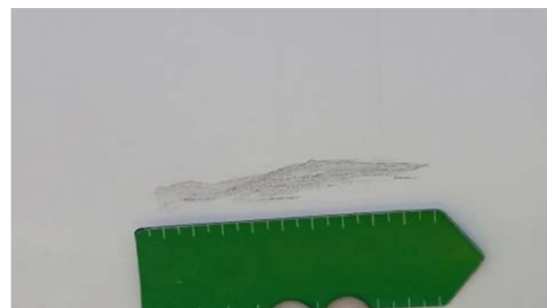
Painéis laterais: risco ligeiro com remoção de material \leq 20 cm
