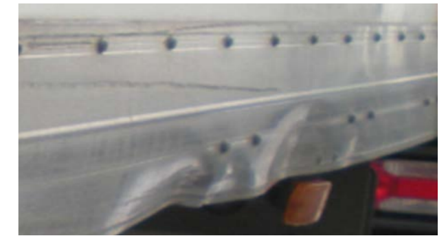
Perfis laterais sob o chassis: deformações excedem a reparação económica, perfurações, remoção de uma secção do perfil
