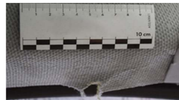
Revestimento de tecido: rasgo, orifício > 5 mm, marcas indeléveis
