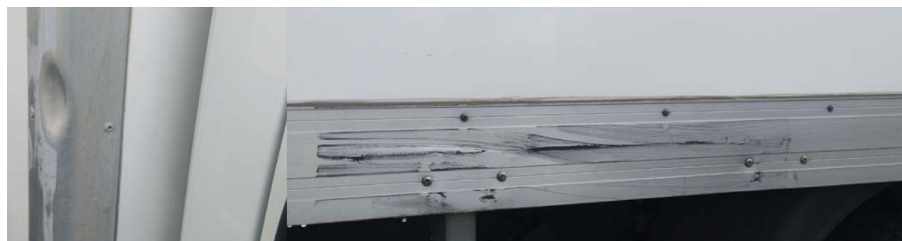
Perfis laterais sob o chassis: deformações dentro da reparação económica
