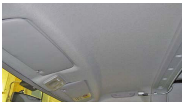
Descoloração ligeira devido aos raios de sol
