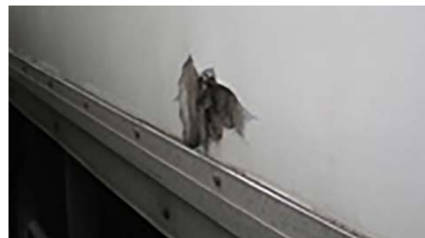
Painéis laterais de madeira: suporte de madeira danificado \geq 20 cm
