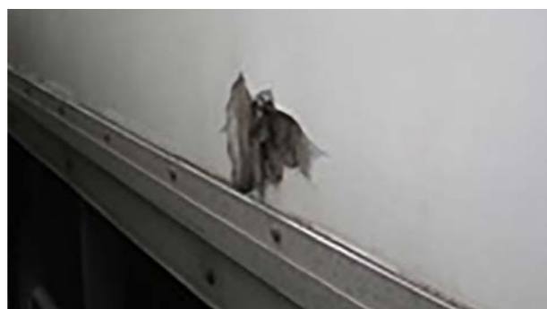
Drveni bočni paneli: Oštećen drveni nosač \geq 20 cm
