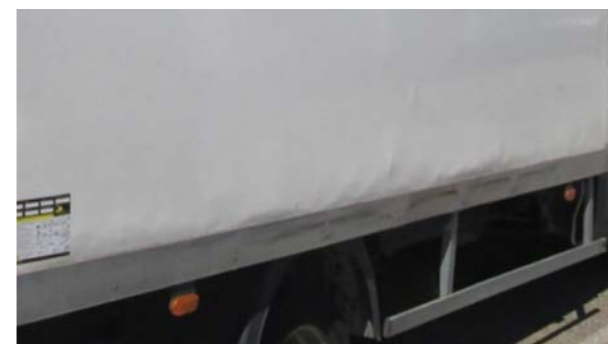
Platneni bočni paneli: Deformacija donjeg dela, dužina od > 1 m NB: Zamena prednjeg panela na trapu zahteva uklanjanje trapa.
