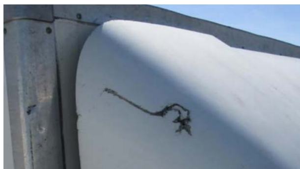
Prostor iznad kabine i deflektor: U okviru ekonomične popravke
