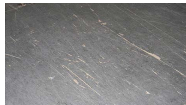
Pod: Blaga deformacija, površinsko habanje
