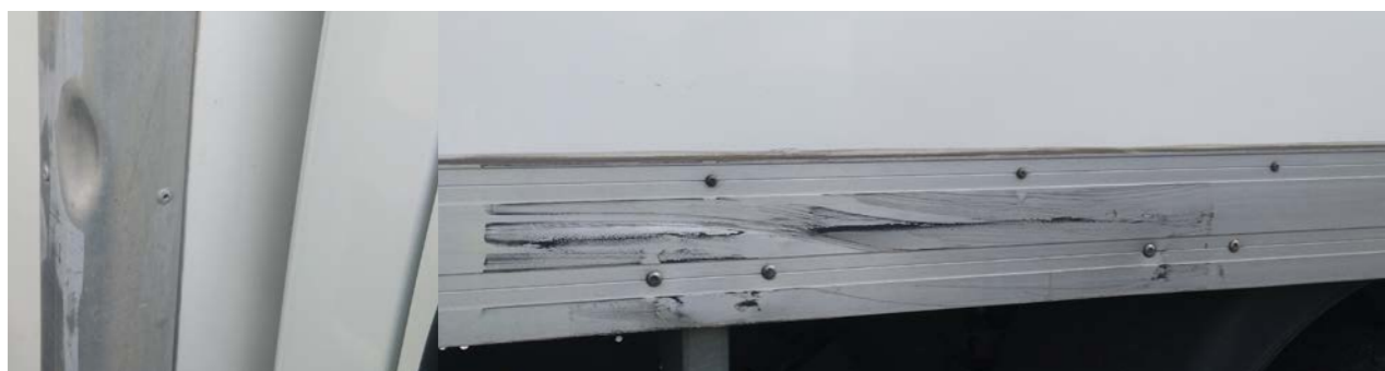
Bottenplattans sidoprofiler: Deformationer med ekonomiskt genomförbara reparationer
