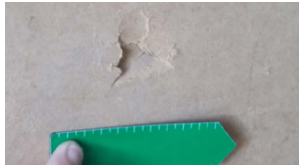
Invändiga träskydd: Småskador
