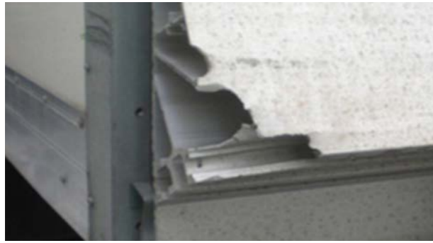
🔄 Bakgavellyft: Deformationer på plattformen bortom ekonomisk reparation, trasig eller ofullständig beläggning
