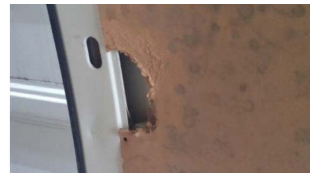
Protecții interne din lemn: Lovituri, panou rupt, panou lipsă (cu excepția panourilor superioare ale ușii)
