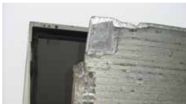
↻ Ladebordwand: Deformationen bzw. Durchbiegung der Plattform, die nicht auf wirtschaftliche Weise repariert werden können, gebrochene oder unvollständige Verkleidungen
