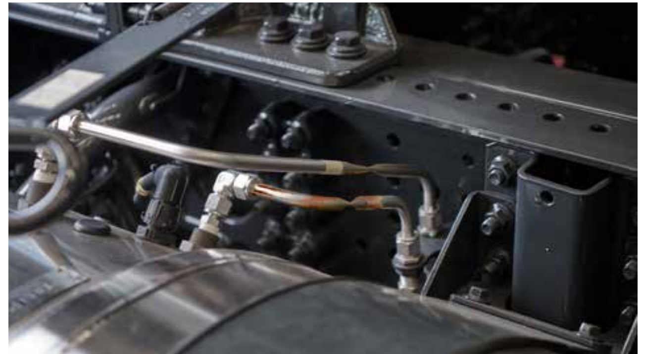
Korózia, preliačiny, praskliny a/alebo ryhy → účtuje sa poplatok za výmenu pevných vedení.
