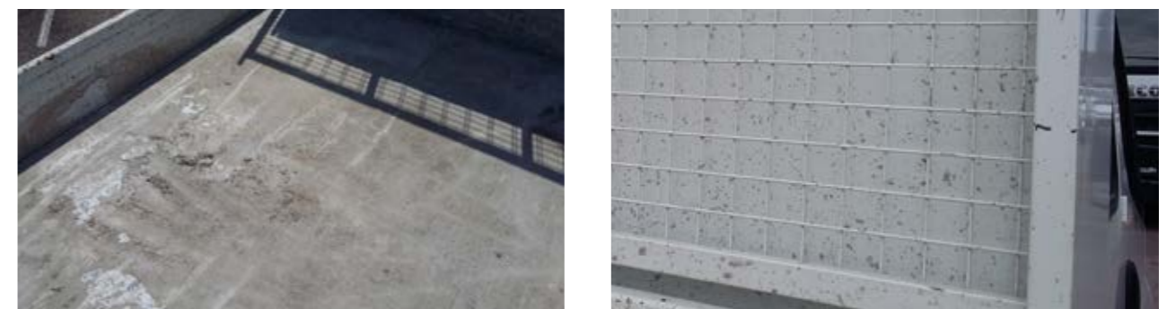
Stopy betonu nebo chemického přípravku, které pokrývají ≥ 1/4 povrchové plochy lůžka
