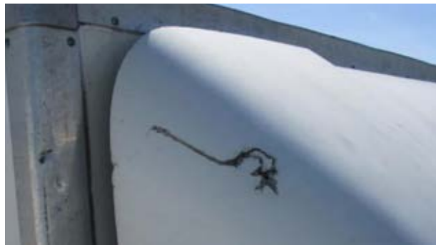
Kabina a deflektor: v rámci ekonomičnosti opravy
