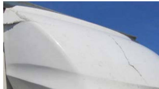
Kabina a deflektor: významná prasklina, chybějící díl nebo nad rámec ekonomičnosti opravy
