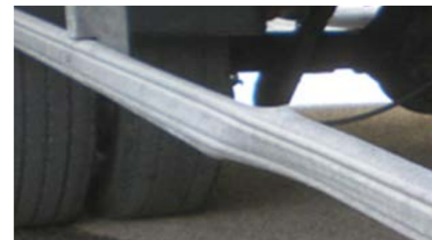
Boční ochrana: deformace nad rámec ekonomičnosti opravy
