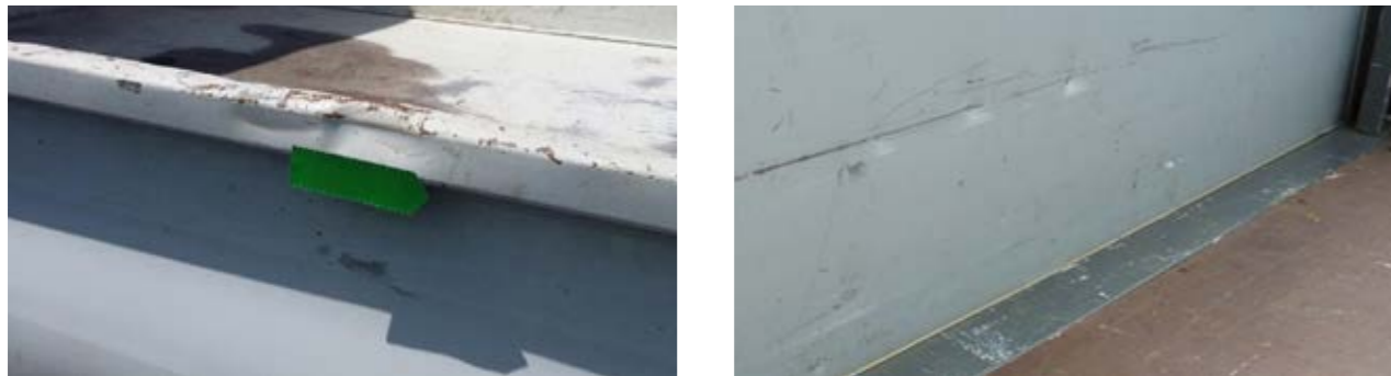
Jemné škrábance, deformace těla bočnice/sklápěče s dobou opravy ≤ 1 h
