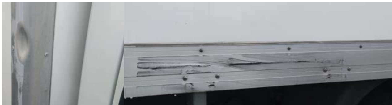
Boční profily nadstavby: deformace v rámci ekonomičnosti opravy
