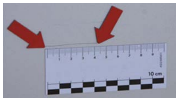
Poškození nebo škrábanec \leq 50 mm, který lze odstranit rozleštěním
