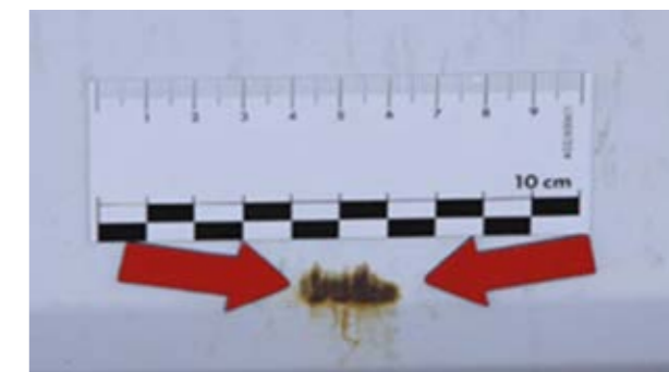
Poškození s korozí, chemické usazeniny nebo jiné, které nelze vyčistit
