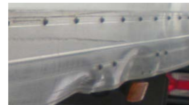
Bočné profily nadstavby: deformácie, ktoré nie sú súčasťou ekonomickej opravy, perforácie, odstránenie časti profilu
