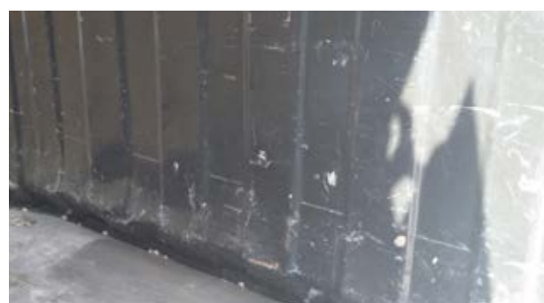
Vnútorne deformácie: jemné deformácie bez perforácii alebo preliačín, čas opravy ≤ 3 h
