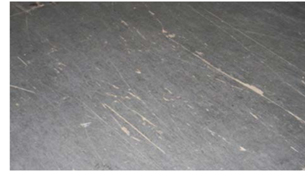
Bodenbelag: Leichte Verformung, oberflächlicher Verschleiß
