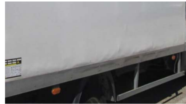
GFK-Seitenverkleidungen: Verformung am Unterteil, Länge > 1\text{ m} Bitte beachten: Der Austausch der vorderen Tafel des Unterbodens erfordert den Ausbau des Unterbodens.
