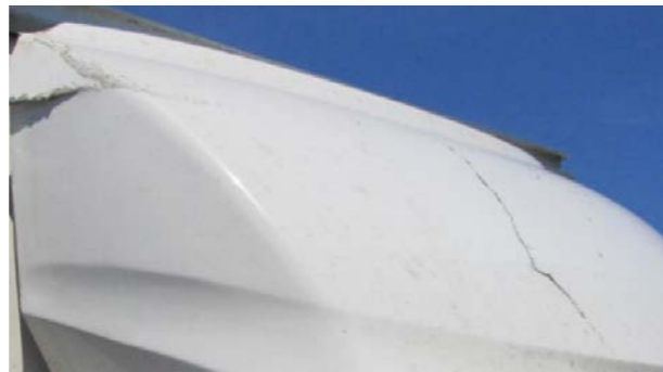
Kabinenabdeckung und Abweiser: Größere Risse, fehlende Teile, kann nicht auf wirtschaftliche Weise repariert werden
