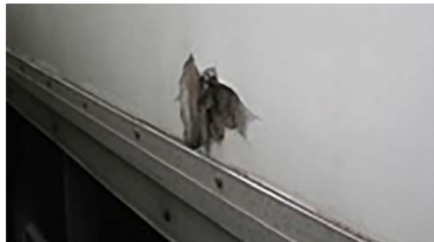
Holzseitenverkleidungen: Beschädigte Holzstütze \geq 20\text{ cm}
