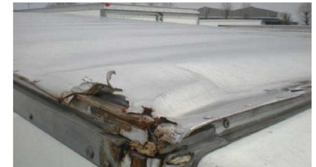
↻ Dachfläche: Rahmen beschädigt, kann nicht auf wirtschaftliche Weise repariert werden
