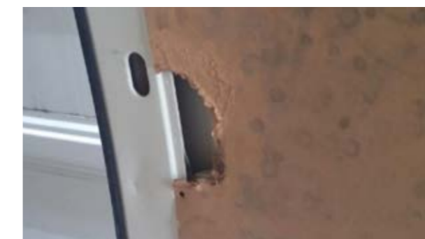
Drvena unutrašnja zaštita: Udari, rascepan panel, panel nedostaje (ne uključujući gornje panele vrata)
