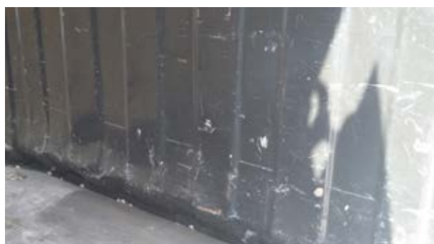
Unutrašnje deformacije: Blaga deformacija bez perforacija ili razreza, vreme popravke ≤ 3 h
