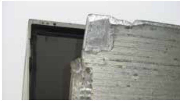
🔄 Sponda caricatrice: deformazioni della piattaforma dalla riparazione antieconomica, rivestimento rotto o incompleto
