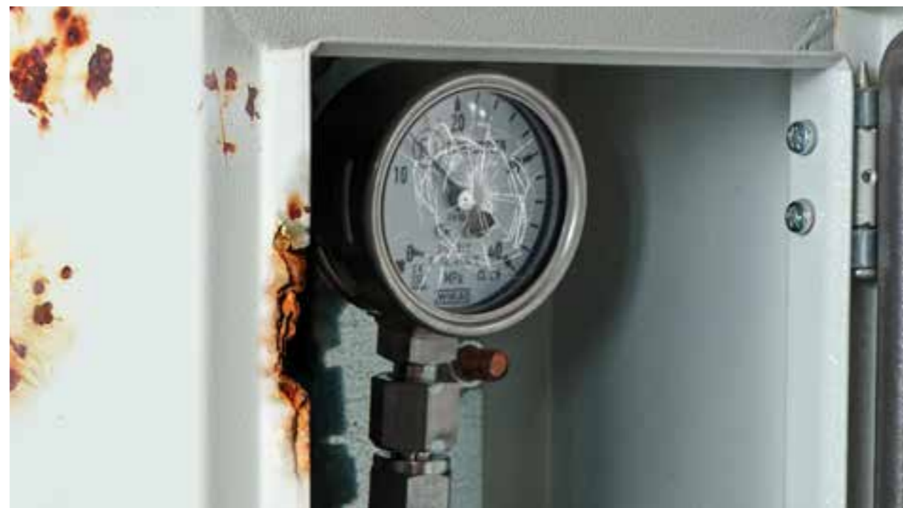
Assenza della chiave della scatola protettiva, danni al bocchettone per il rifornimento di CNG o al manometro → importo relativo alla sostituzione dell'intera scatola.
