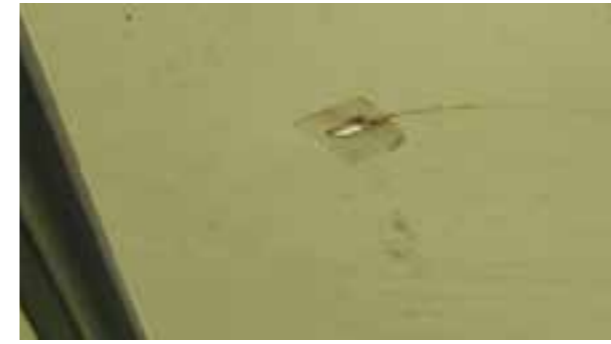
🔧 Padiglione: perforato o strappato e dalla riparazione economicamente conveniente
