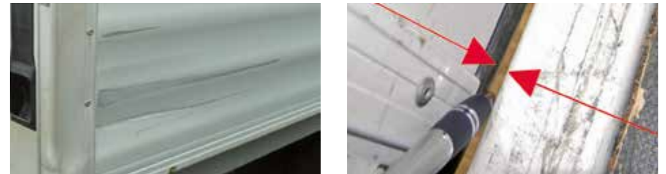
Deformazioni nelle sponde dalla riparazione economicamente conveniente, chiusura impossibile o non a tenuta contro la sabbia
