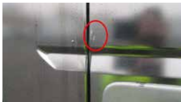
Пукнатина на работ на вратата
