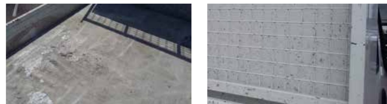
Трага од бетон или хемиски производ што покрива \geq 1/4 од површината на контејнерот
