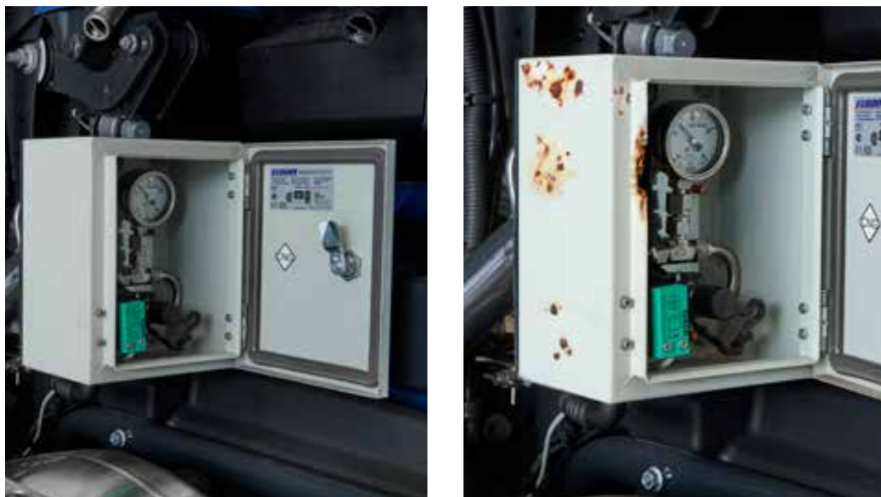
Корозија на заштитната кутија на отворот за полнење → напомена без надоместок за штета.
