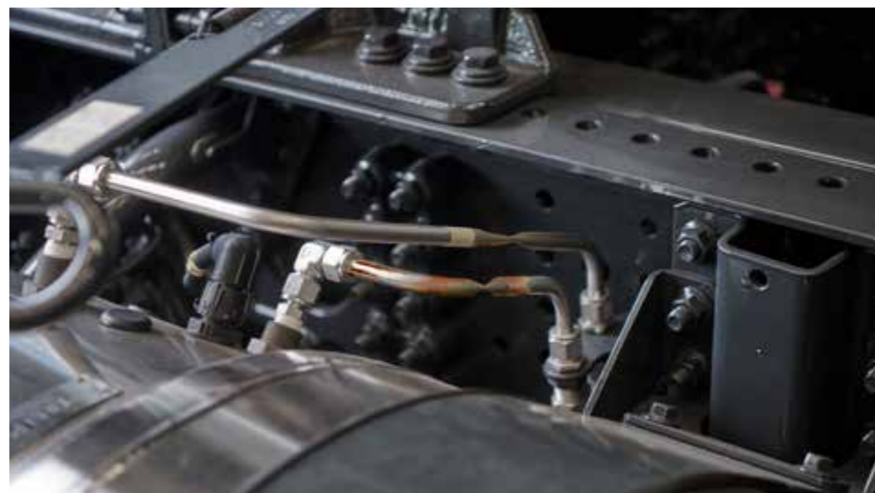
Корозија, вдабнатини, расцепи и/или пукнатини → надоместок за замена на непропустливи цевки.
