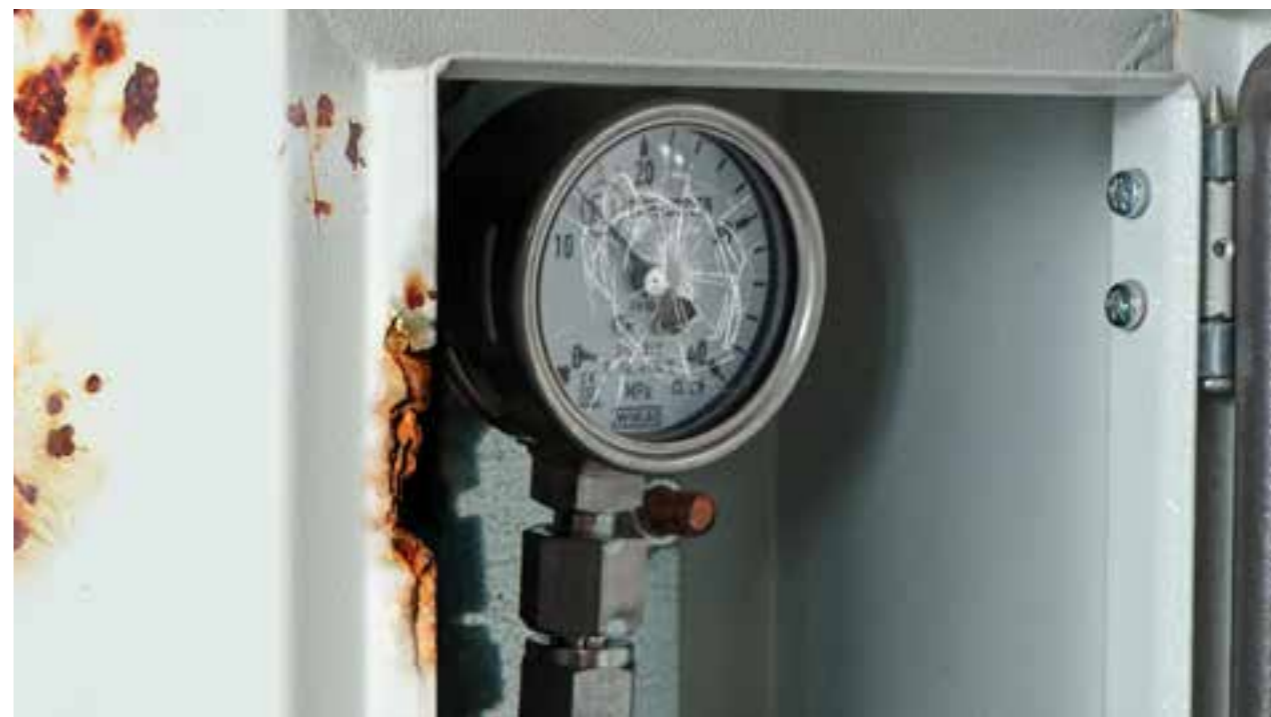
Недостасува клучот од заштитната кутија, оштетен е отворот за полнење на CNG или манометарот → надоместок за целосна замена на кутијата.
