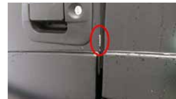
Пукнатина на работ на вратата
