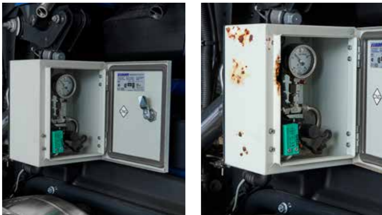
Rdza na pojemniku ochronnym zbiornika napełniającego → uwaga bez opłat za uszkodzenie.
