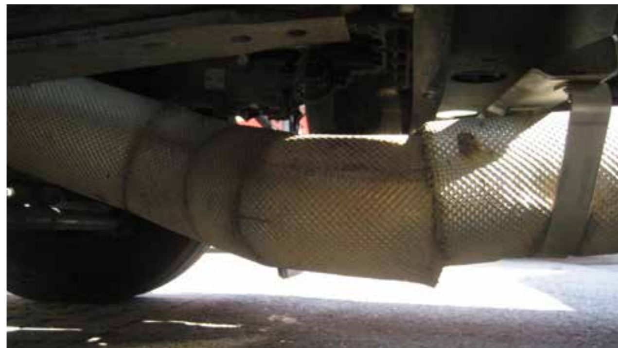
Niedopuszczalne są: pęknięte rury, rozerwana izolacja termiczna, głębokie rysy w materiale, wgniecenia zmniejszające średnicę rury.
