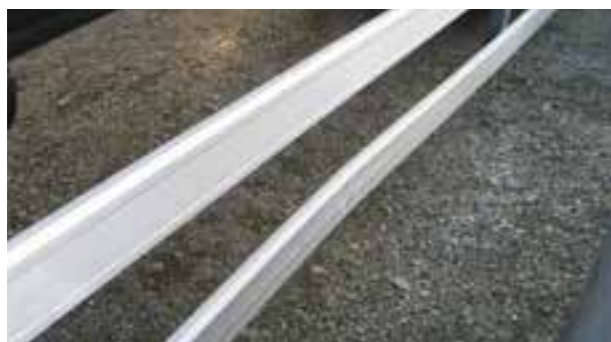
✂ Suportes inferiores: deformação dentro da reparação económica
