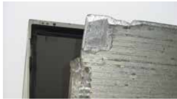
⌚ Taipal de carregamento: deformações da plataforma que excedam a reparação económica, revestimento partido ou incompleto
