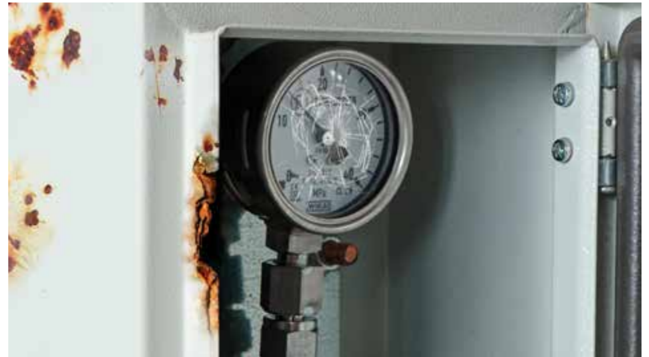
Chave da caixa de proteção em falta, manómetro ou recipiente GNC danificado → cobrança da substituição da caixa completa.
