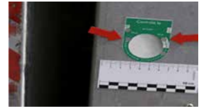
🔧 Taipal de carregamento: datas de verificação expiradas
