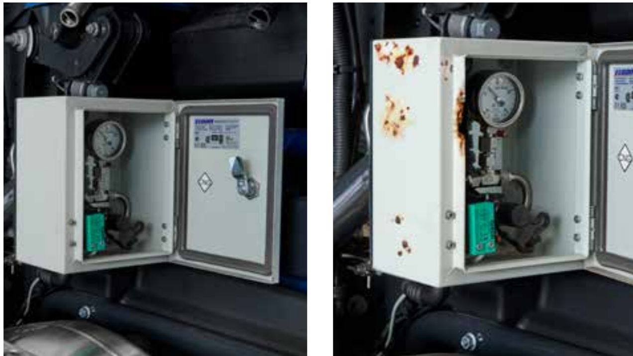
Ferrugem na caixa de proteção da tomada de enchimento → nota sem cobrança por dano.
