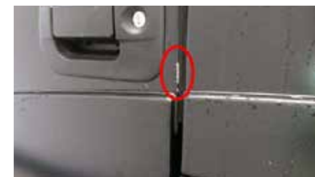
Fisură pe marginea ușii
