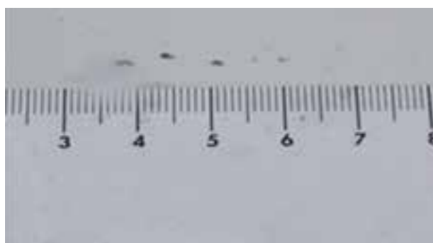
Fisură \leq 5 mm în diametru și \leq 20 de fisuri
