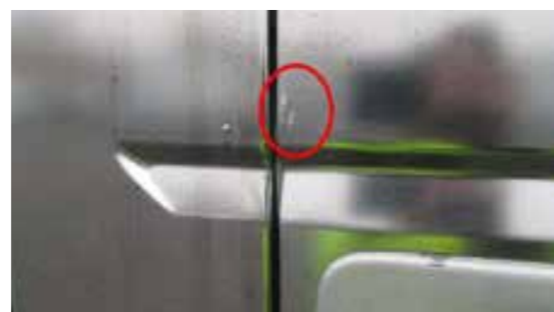
Fisură pe marginea ușii
