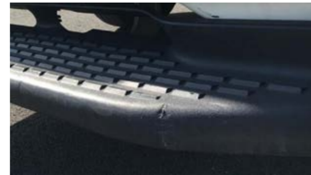
🔧 Stražnje stepenice: Deformacije unutar ekonomski isplativog popravka
