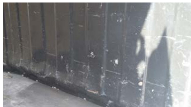
Odkształcenia wewnętrzne: Niewielkie odkształcenia bez perforacji lub nacięć, czas naprawy ≤ 3 h
