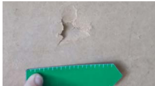
Wewnętrzne osłony drewniane: Niewielkie ślady uderzeń
