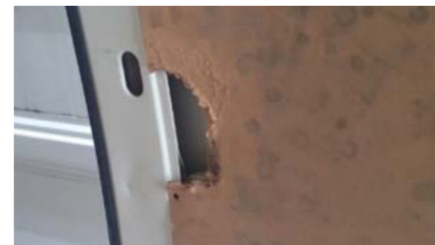
Wewnętrzne osłony drewniane: Ślady uderzeń, rozdarty panel, brak panelu (nie dotyczy górnych paneli drzwiowych)
