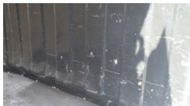
Deformações internas: ligeira deformação sem perfurações ou cortes, tempo de reparação ≤ 3 h
