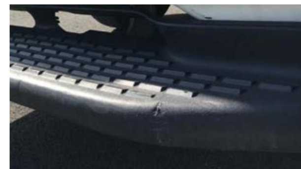
Plataformas traseiras: deformações dentro da reparação económica
