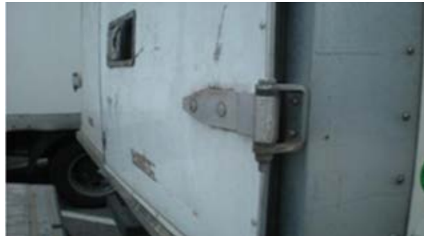
↻ Portas laterais e traseiras: portas dobradas nos pontos de fixação das dobradiças, partidas, perfuradas ou excedem a reparação económica
