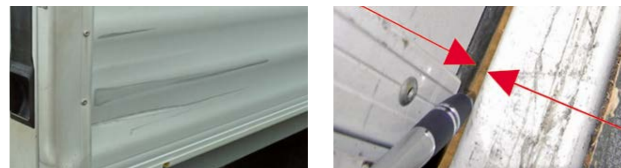
Deformações nos rails não excedem a reparação económica, fecho não possível ou não à prova de areia
