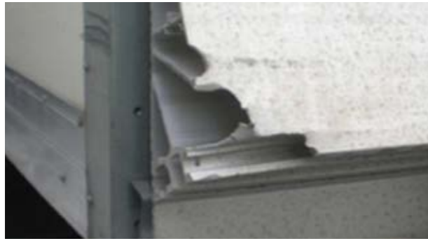
↻ Taipal de carregamento: deformações da plataforma excedem a reparação económica, revestimento partido ou incompleto
