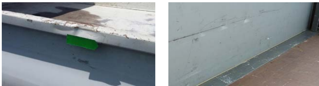
Riscos ligeiros, deformações do rail com um tempo de reparação \leq 1 h
