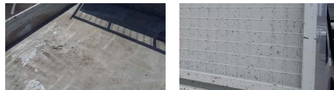
Vestígios de betão ou produto químico cobrindo \geq ¼ da superfície da tremonha
