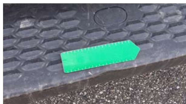
Trepte spate: Deformare ușoară
