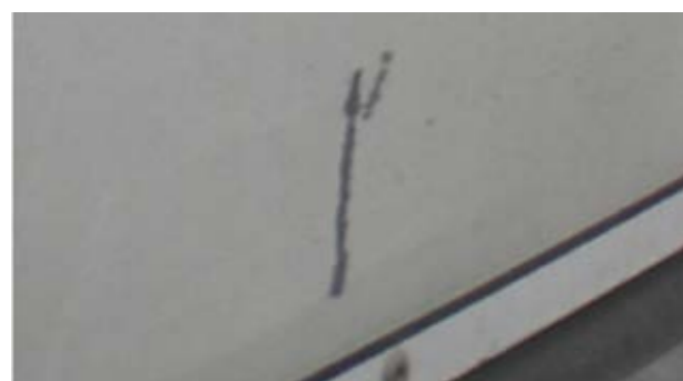
📋 Uși laterale și spate: Deformare ușoară: Durată de reparare \leq 1 h
