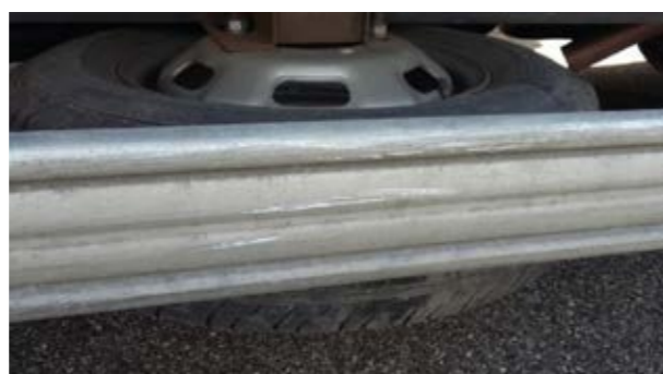
📋 Protecții de bicicletă: Zgârietură ușoară
