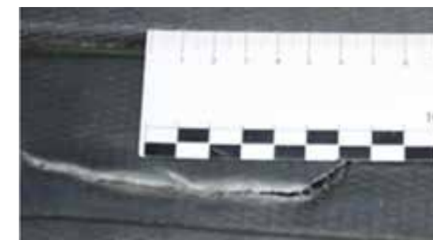
Perforatie van harde kunststof bekleding. Reparatie van hard kunststof bekleding | standaard uurtarief indien esthetisch acceptabel en reparabel
