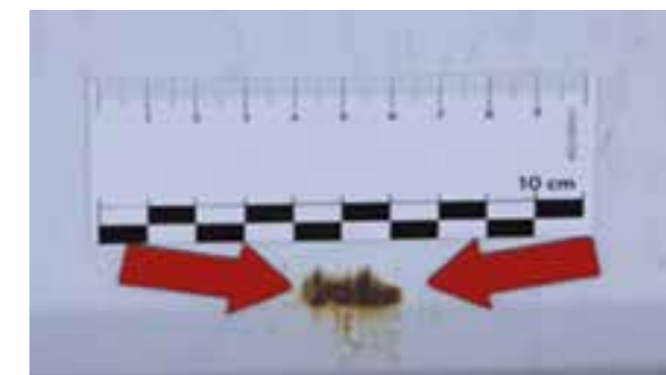
Krassen met roestvorming, chemische aanslag of anders, dat niet kan worden gereinigd
